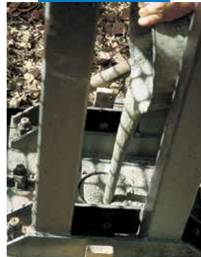
Anclaje con Mapefill E
